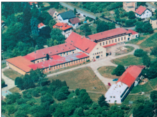
Hradištko - letecký pohled na objekt tiskárny.
