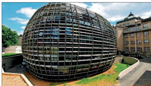
Nová budova ústavu architektů Šroma a Maškové, nazývaná též „Květák“.
