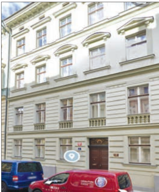
Dům č. 4 dnes. Po obchodu JF II. v něm už není ani památka. Nacházel se v přízemí, vlevo od vchodu do domu, a v prvním okně byl původně vchod do krámu, místo druhého byla výloha. Později byl obchod zrušen a jeho prostory přeměněny na byt.
