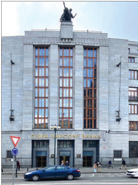
Čelo historické budovy Živnostenské banky v Praze Na příkopě, postavené v letech 1935 až 1942. V roce 1950 zde bylo zřízeno ústředí Státní banky Československé a v roce 1993 ústředí České národní banky. Hlavním vchodem zachyceným na fotografii vstoupíte přímo do expozice.
