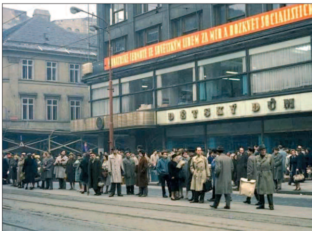
Zastávka tramvaje před Dětským domem, vlevo chátrající budova POFISu s poškozenou střechou a nouzovým dřevěným „podloubím“.
